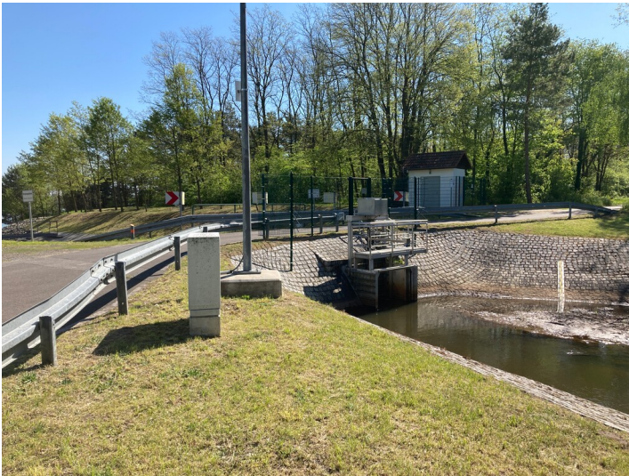
Zulauf Bernsteinsee mit Betriebsgebäude und befahrbarem Durchlass, Blick in Richtung See Fotograf/Urheber: Kathrin Krüner
