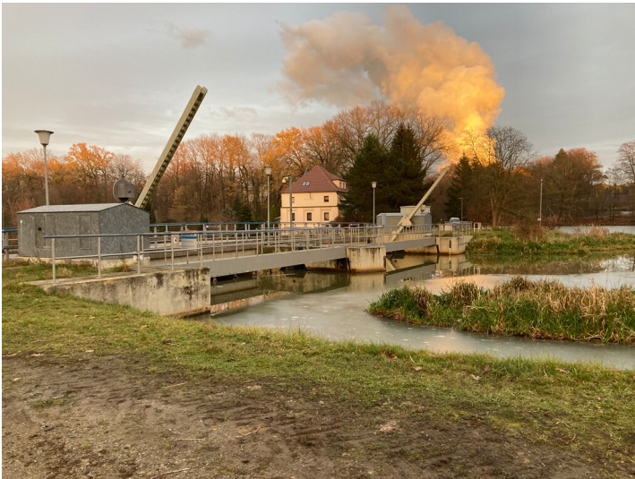
Wehranlage im Flusslauf der Spree Fotograf/Urheber: Matin Neubacher
