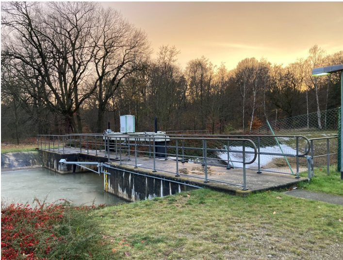
Blick auf das Bauwerk welches den Zulauf zum Speicherbecken Lohsa II reguliert Fotograf/Urheber: Matin Neubacher
