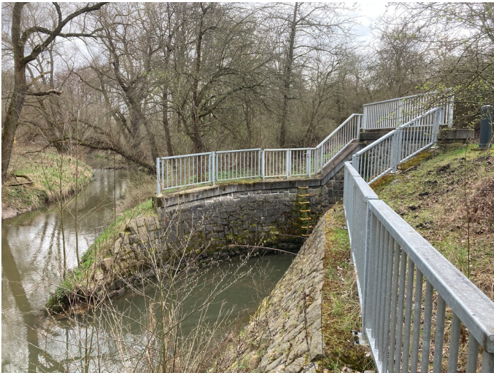
Auslaufbauwerk Speicher Lobstädt mit untertägigem Durchlass, Blick in Richtung Süden Fotograf/Urheber: Vincent Haburaj
