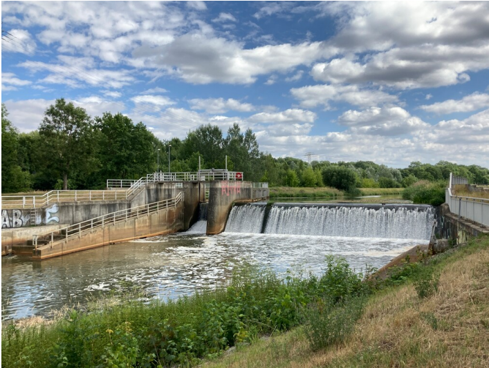
Agra-Wehr zur Regulierung des Abflussverhaltens der Pleiße, Blick von Nordwest. Fotograf/Urheber: Josephine Dressler
