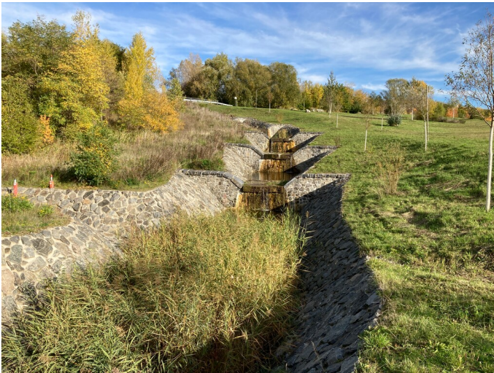
Als Kaskaden angelegter Zulauf zum Störmthaler See, Blick in Richtung Osten Fotograf/Urheber: Josephine Dressler
