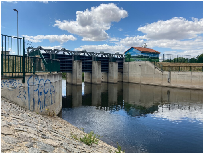
Anlage im Flusslauf der Weißen Elster, Blick flussaufwärts Fotograf/Urheber: Vincent Haburaj
