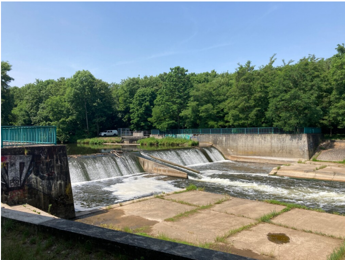
Wasserbauliche Anlage zur Regulierung des Abflussverhaltens mit Fischtreppe, Blick vom Ostufer flußaufwärts Fotograf/Urheber: Vincent Haburaj
