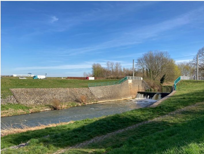
Wehranlage in der Pleiße, Blick flussaufwärts Fotograf/Urheber: Vincent Haburaj
