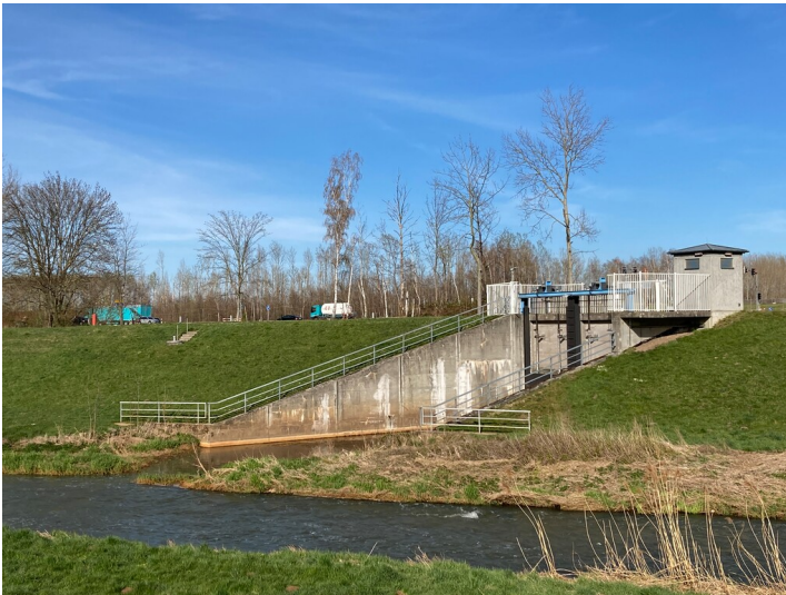
Auslaufbauwerk an der Pleiße, Blick in Richtung Osten Fotograf/Urheber: Vincent Haburaj
