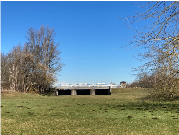
Zulauf Rückhaltebecken Stöhna, Blick von der Pleiße aus in Richtung Norden Fotograf/Urheber: Vincent Haburaj
