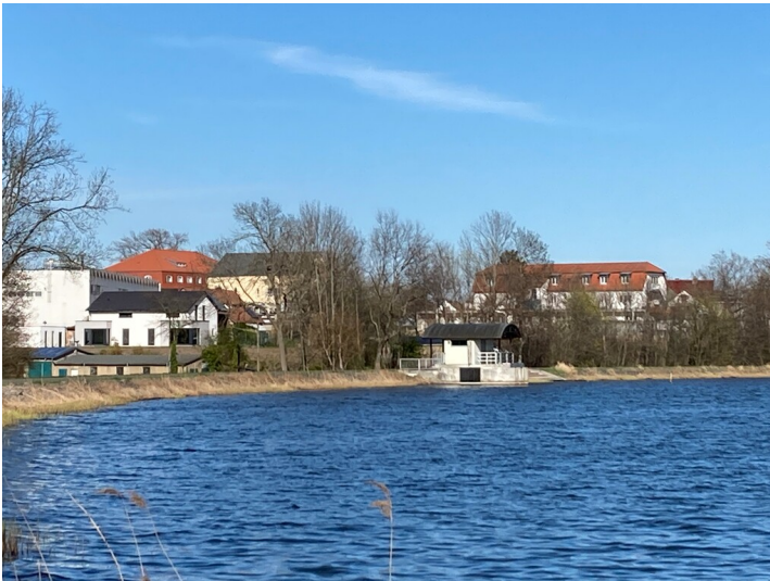
Auslaufbauwerk seeseitig mit Blick nach Norden Fotograf/Urheber: Vincent Haburaj
