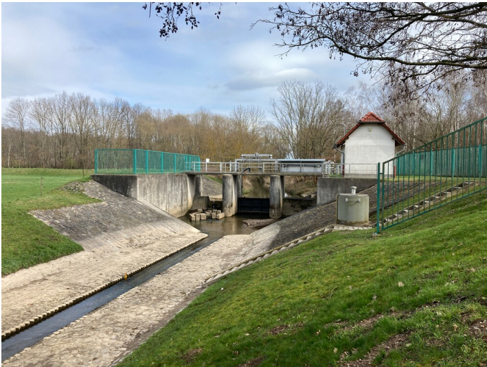
Zulauf zum Speicherbecken Witznitz, Blick in Richtung Osten Fotograf/Urheber: Vincent Haburaj
