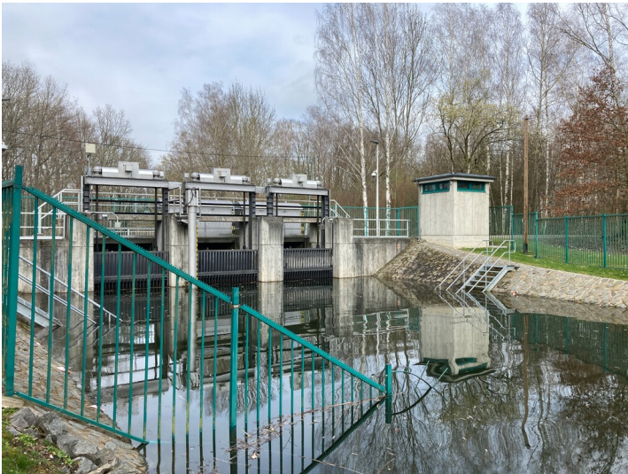
Auslaufbauwerk Speicherbecken Witznitz mit Ausleitgraben, Blick in Richtung Norden Fotograf/Urheber: Vincent Haburaj
