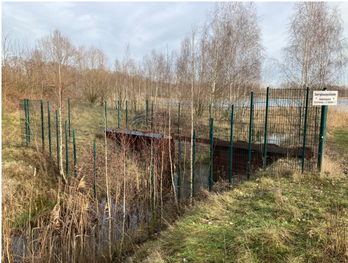
Auslaufbauwerk Bockwitzer See mit Dammbalkenwehr, Blick in Richtung Osten Fotograf/Urheber: Josephine Dressler
