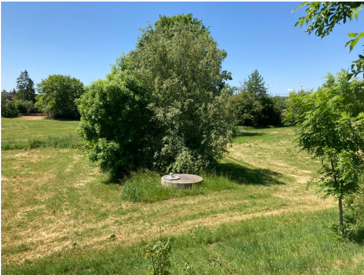
Auslaufbauwerk Haselbacher See mit Ausleitgraben Fotograf/Urheber: Josephine Dressler
