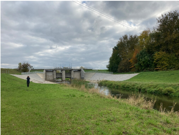
Das Wehr im Lauf der Pleiße, zugehörig zum Zulauf des Rückhaltebeckens Borna und Regis-Serbitz, Blick in Richtung Süden Fotograf/Urheber: Vincent Haburaj
