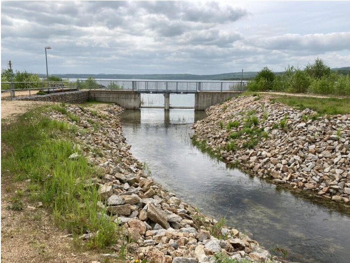
Auslaufbauwerk Berzdorfer See, Blick in Richtung See Fotograf/Urheber: Nora Wiedemann
