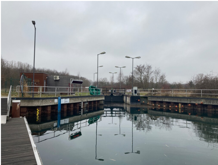
Seeseitiger Blick auf die wasserbauliche Anlage mit Anlegesteg Fotograf/Urheber: Vincent Haburaj
