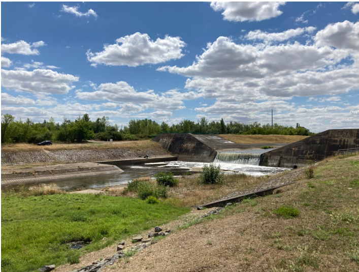
Blick flussaufwärts auf die Staustufe Fotograf/Urheber: Vincent Haburaj
