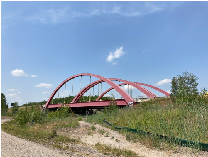
Blick auf die Autobahnbrücke über den ursprünglich geplanten Harthkanal, Blick in Richtung Norden Fotograf/Urheber: Vincent Haburaj
