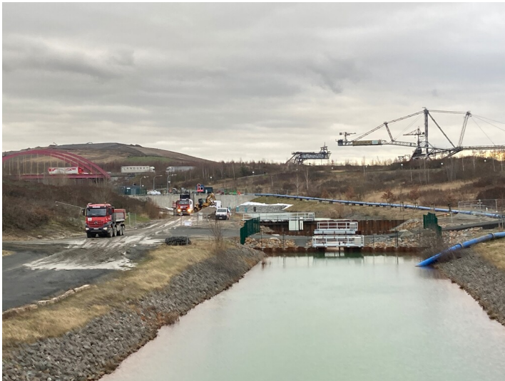
Blick nach Süden auf die Schleusenanlage mit zugehörigem Kanal und Autobahnbrücke. Fotograf/Urheber: Vincent Haburaj
