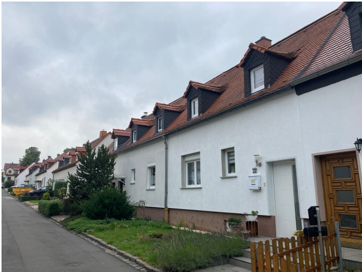
Bergarbeitersiedlung Kitzscher, Reihenhauszeilen an der Schloßstraße, Blick nach Nordost Fotograf/Urheber: Vincent Haburaj
