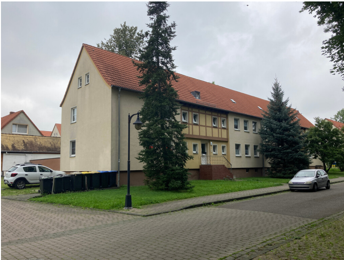
Bergarbeitersiedlung Kitzscher, Mehrfamilienwohnhäuser an der Parkstraße, Blick nach Nordost Fotograf/Urheber: Vincent Haburaj
