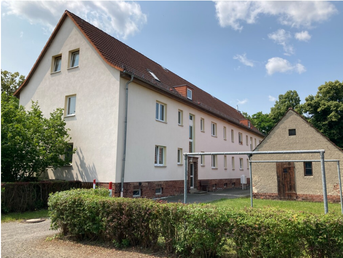
Exemplarischer Blick auf ein Haus mit Eingang und rückliegendem Nebengebäude Fotograf/Urheber: Josephine Dreßler
