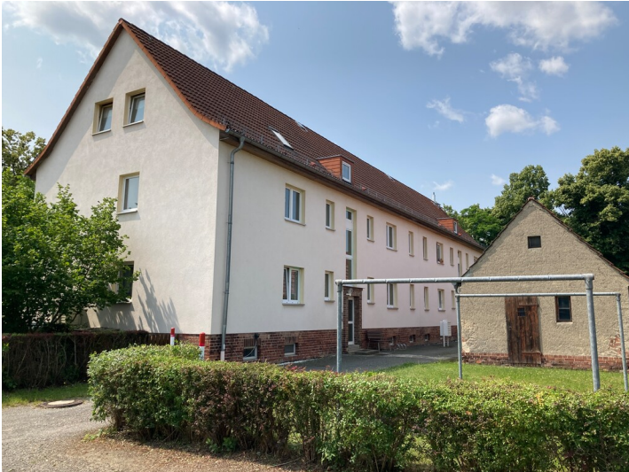
Exemplarischer Blick auf ein Haus mit Eingang und rückliegendem Nebengebäude Fotograf/Urheber: Josephine Dreßler
