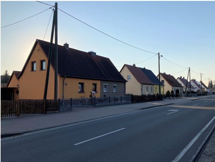
Blick von Südosten entlang der Heuersdorfer Straße auf die sieben Doppelhäuser Fotograf/Urheber: Isabell Schmock-Wieczorek
