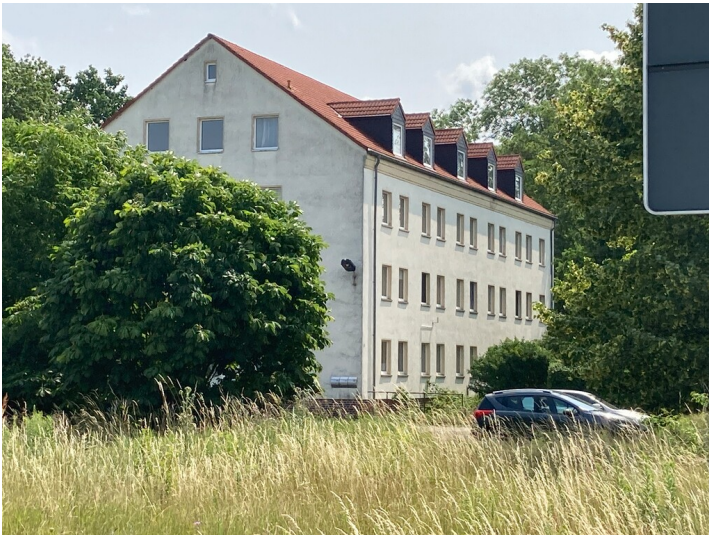
Blick von Nordwesten auf das ehemalige Arbeiterwohnhaus Fotograf/Urheber: Josephine Dreßler
