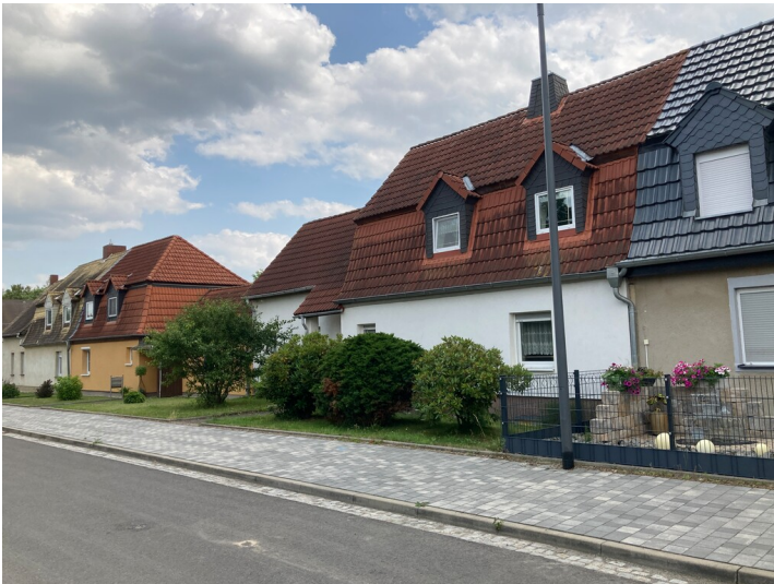
Zwei Doppelwohnhäuser, das apricotfarbene Haus ist strukturell am besten erhalten, Blick von Nordwesten Fotograf/Urheber: Josephine Dreßler
