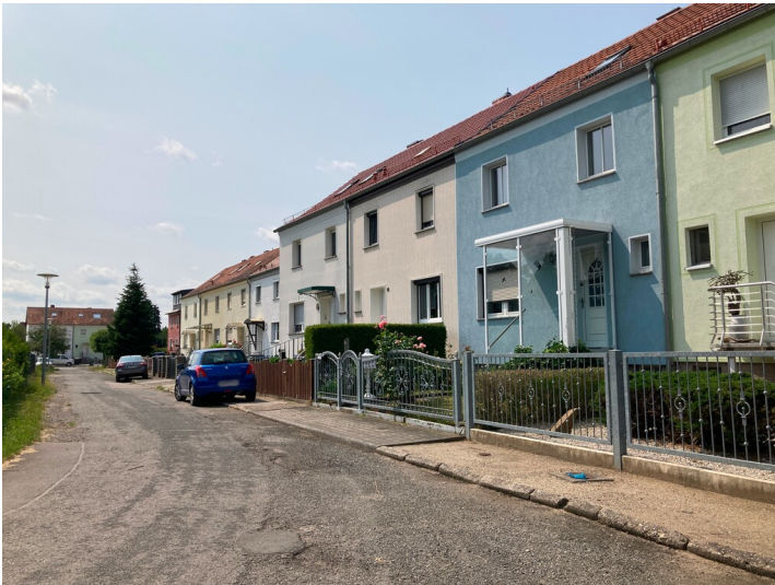
Blick von Nordosten auf die Einfamilienhäuser Fotograf/Urheber: Josephine Dreßler
