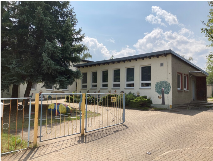
Kindergarten, Blick von Nordosten, vorn einer der beiden Anbauten Fotograf/Urheber: Josephine Dreßler
