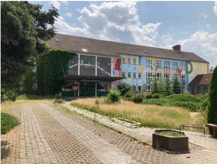
Blick aus Norden auf die Schule mit dem Haupteingang Fotograf/Urheber: Josephine Dreßler
