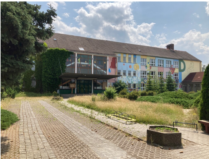
Blick aus Norden auf die Schule mit dem Haupteingang Fotograf/Urheber: Josephine Dreßler
