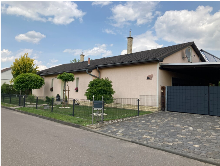
Blick von Südwesten auf die einstige Notschule, die heute zum Wohnhaus umgebaut ist Fotograf/Urheber: Josephine Dreßler
