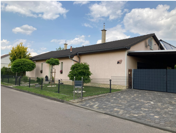
Blick von Südwesten auf die einstige Notschule, die heute zum Wohnhaus umgebaut ist Fotograf/Urheber: Josephine Dreßler
