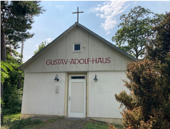
Der Eingangsgiebel nach Osten Fotograf/Urheber: Josephine Dreßler
