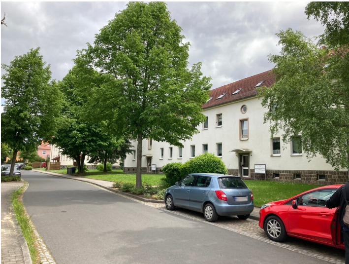
Mehrfamilienhäuser, Blick von Nordwesten auf die beiden östlichen, zweispännigen Bauten Fotograf/Urheber: Josephine Dreßler
