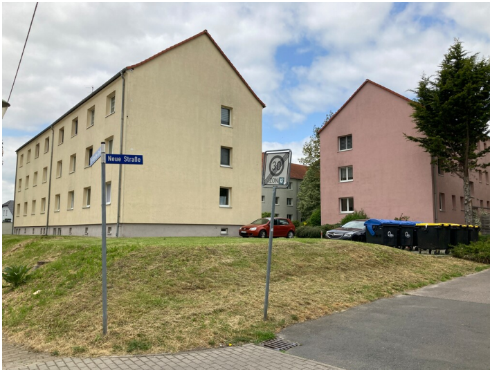
Drei Mehrfamilienwohnhäuser, gelb zur Alt-Witznitzer-Straße von 1958, rosa zur Neuen Straße von 1960 Fotograf/Urheber: Josephine Dreßler
