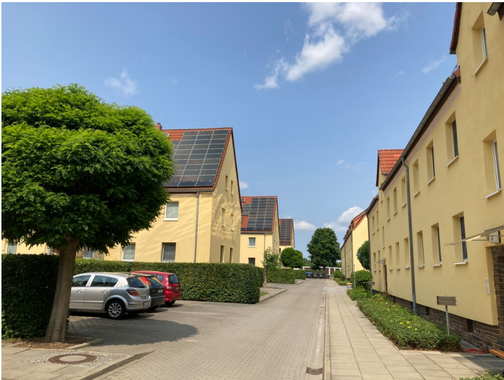
Kuchenstück-Siedlung, Blick nach Nordwesten Fotograf/Urheber: Josephine Dreßler
