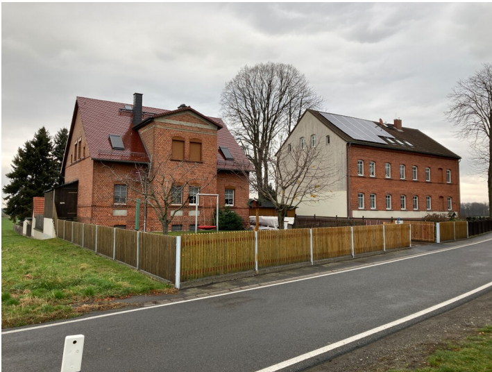
Ehemals Braunkohlenwerk Gewerkschaft Graf Moltke, später Stockheimer Kohlenwerke, rechts das Verwaltungs- und Beamtenhaus, links das Direktorenhaus, Blick von Südwesten Fotograf/Urheber: Ullrich Ochs
