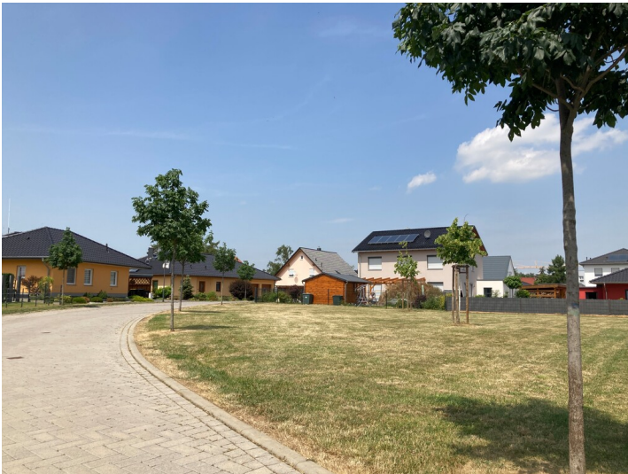
Der zu sehende und namensgebende Bogen ist innen teils als Grünfläche gestaltet und außen bebaut. Blick aus Südosten Fotograf/Urheber: Josephine Dreßler
