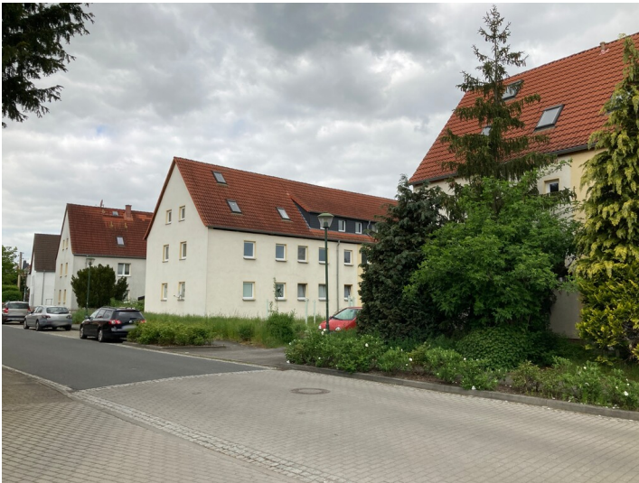
Vier Mehrfamilienwohnhäuser, Blick von Osten, vorn Nr. 39/41 Fotograf/Urheber: Josephine Dreßler
