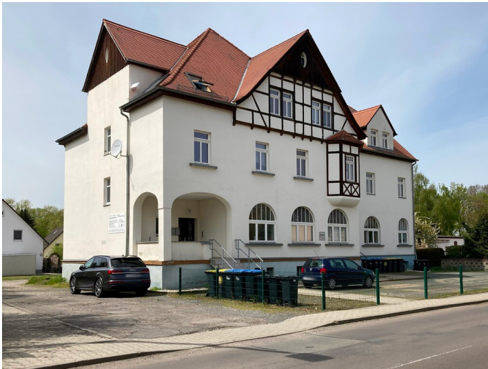
Ehemaliges Gasthaus »Neue Welt«, Blick von Südosten Fotograf/Urheber: Josephine Dreßler
