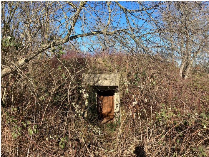
Eingang zum ehemaligen Sprengstofflager für den Tagebau Witznitz II Fotograf/Urheber: Vincent Haburaj
