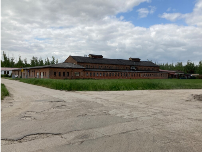
Ehemalige Tagesanlagen des Tagebaus Witznitz II, Blick von Nordosten auf einen Teil des Areals Fotograf/Urheber: Josephine Dreßler
