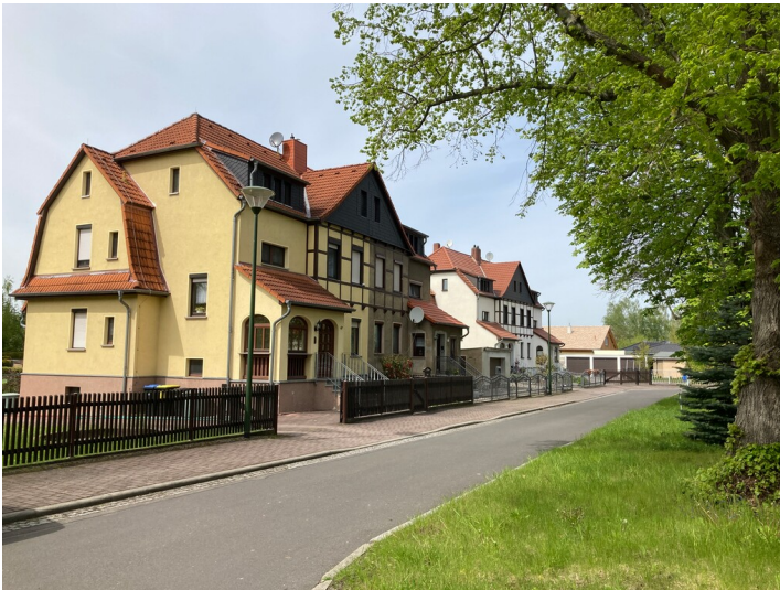
Ehemalige Beamtensiedlung, hier mit zwei Doppelhäusern im Westen, rechts die Grünfläche mit Baumreihe Fotograf/Urheber: Josephine Dreßler
