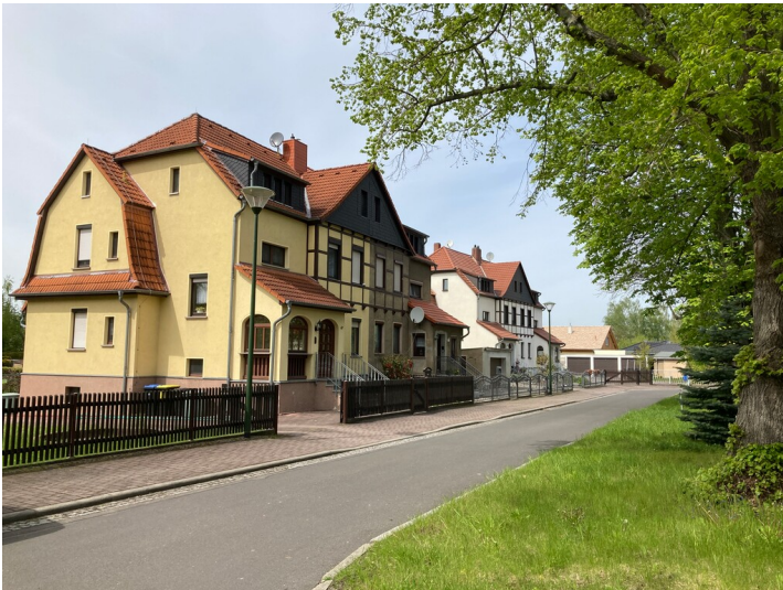
Ehemalige Beamtensiedlung, hier mit zwei Doppelhäusern im Westen, rechts die Grünfläche mit Baumreihe Fotograf/Urheber: Josephine Dreßler
