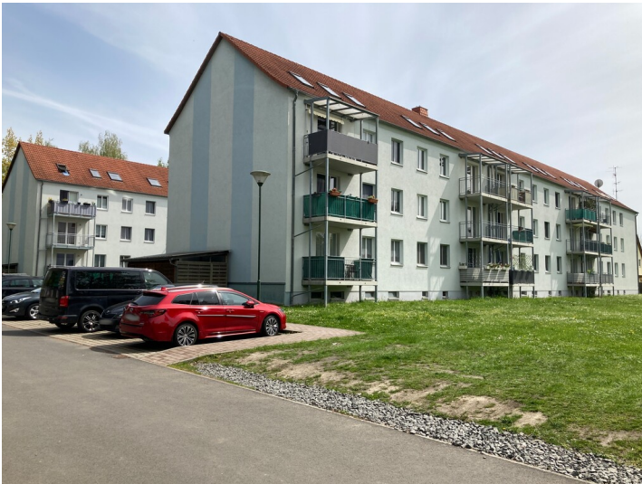
Rückseite der beiden Wohnblöcke, Blick von Nordwesten Fotograf/Urheber: Josephine Dreßler
