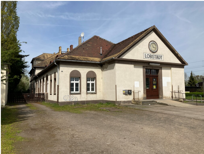
Eingang zur ehemaligen Schalterhalle des Bahnhofs Lobstädt, Blick von Südosten Fotograf/Urheber: Josephine Dreßler
