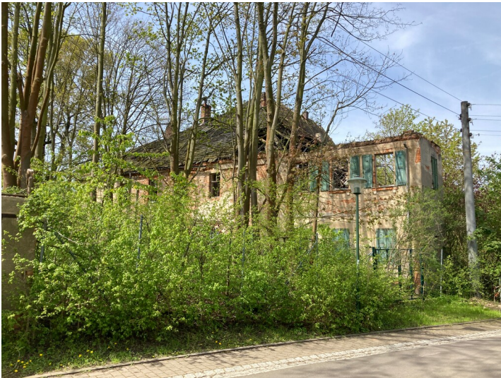
Schloss in Lobstädt, aktuell akut gefährdet und eingewachsen, Blick von der Schloßstraße Fotograf/Urheber: Josephine Dreßler
