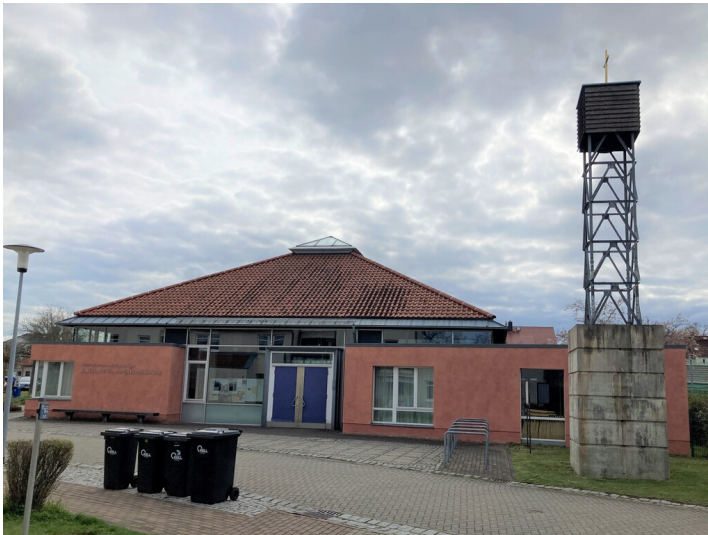
Kirchengebäude mit Glockenturm, Blick von Nordosten Fotograf/Urheber: Josephine Dressler
