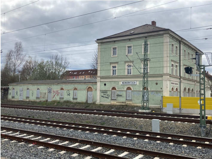
Bahnhof Neukieritzsch, das Empfangsgebäude mit eingeschossigem Anbau, Blick von Osten Fotograf/Urheber: Josephine Dressler
