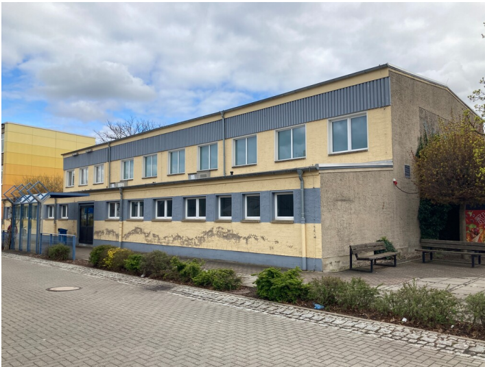
Turnhalle der Siedlung Neukieritzsch-Nord, Blick von Westen, rechts die Giebelseite zur Leipziger Straße mit dem Wandbild Fotograf/Urheber: Josephine Dressler
