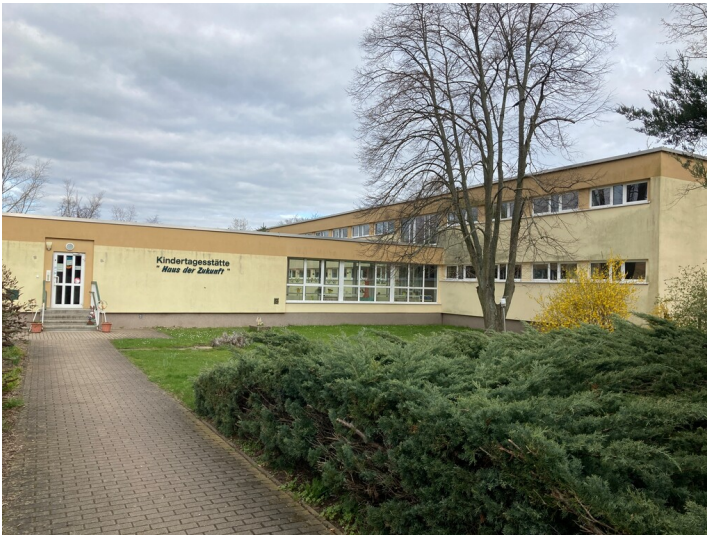
Ehemalige Kinderkombination der Siedlung Neukieritzsch-Nord, Blick auf den westlichen Verbindungstrakt und den südlichen, zweigeschossigen Baukörper Fotograf/Urheber: Josephine Dressler
