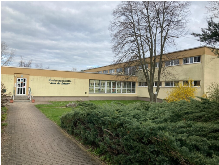
Ehemalige Kinderkombination der Siedlung Neukieritzsch-Nord, Blick auf den westlichen Verbindungstrakt und den südlichen, zweigeschossigen Baukörper Fotograf/Urheber: Josephine Dressler
